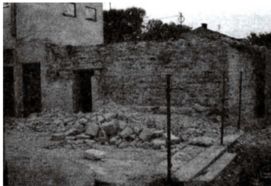
Prace rozbiórkowe przy bunkrze gestapo, w którym byli uwięzieni profesorowie i uczniowie. Izbica, wrzesień 2006. Duże, regularne kamienie to macewy, żydowski nagrobki.
