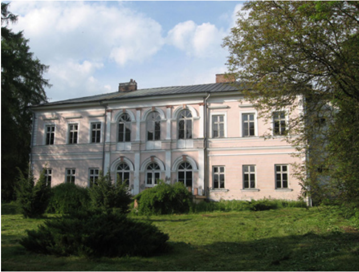
Pałac, widok od strony ogrodu, fot. A. Szykuła-Żygawska, 2006 r.
