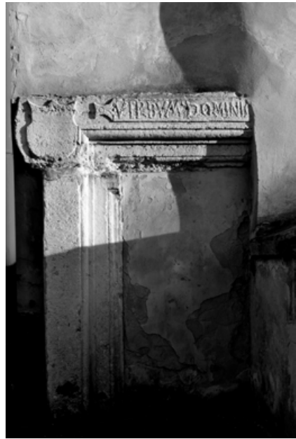
Odrzwia pochodzące z założenia zamkowego w Krasnymstawie wmurowane w narożnik pałacyku biskupiego przez Macieja Bayera, inżyniera, budowniczego drogi Lublin-Zamość, ówczesnego właściciela budynku (fot. K. Grochecki 2014).
